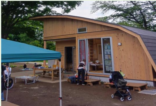
2025年3月に完成した プレーパークリーダーハウス
